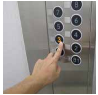
エレベーター扉・パネル
