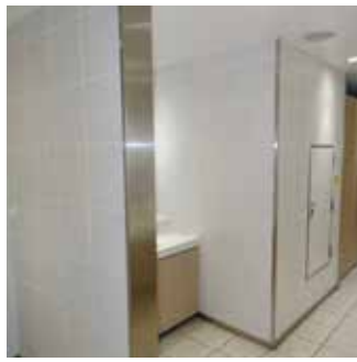
トイレ内ステンレス壁・柱
